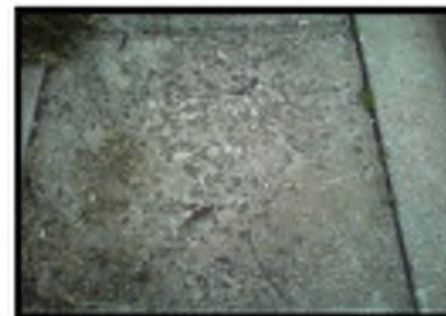
Spalling
